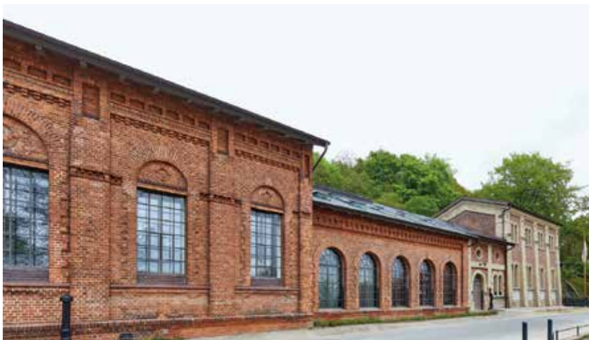
Ensemble Waterworks: Elbseite mit denkmalgeschützten Fensterfronten
