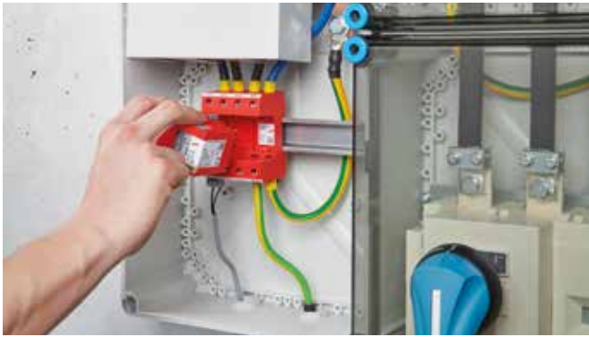
DEHNventil – Schneller und kraftsparender Modulwechsel.
