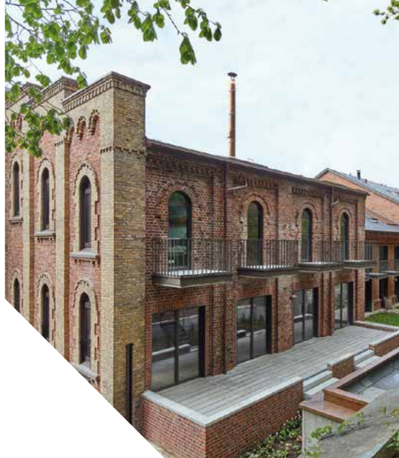
Ensemble Waterworks Rückfront mit neugeschaffenen Austritten und Terrassen.
