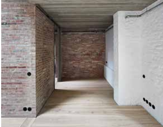
Alt und neu im Dialog: Die geschlammte Original-Ziegelwand trifft auf eine neue Ziegelfront und Betondecke, Dinesen-Dielen und die Berker Serie 1930.
