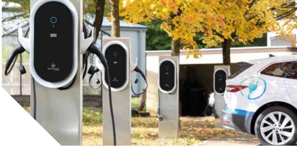
Ausgewählte Ladestationen sind zusätzlich – dank eines integrierten Zählers – ideal für den Ausbau der Ladeinfrastruktur im halböffentlichen Bereich geeignet. Alle TechniVolt Wallboxen sind KfW förderfähig. Das E-Mobility-Unternehmen wird ab Frühjahr 2022 zudem einen umfangreichen Ladeservice an über 100.000 Ladestationen weltweit anbieten, wo Kunden einfach per App oder Ladekarte an öffentlichen Ladepunkten laden können.
