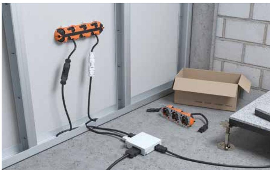
Mit den O-range ECON®-Geräte-Verbindungsboxen in 2-, 3- und 4-fach-Ausführung lassen sich steckbare Baugruppen für Schalter, Steckdosen und andere Geräte in Hohlwänden vorkonfektionieren. Erste Komponentenhersteller haben hier entsprechend werksseitig montierte, verdrahtete und geprüfte Baugruppen im Angebot.
